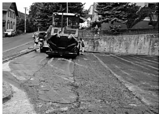
Finišér při pokládce asfaltu
