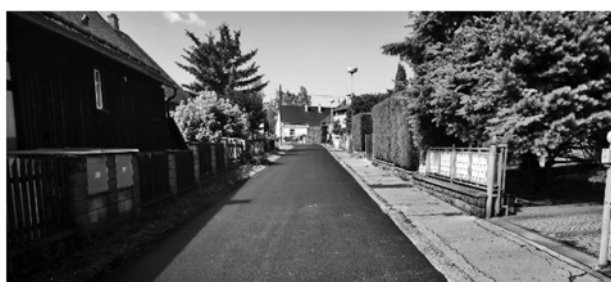
Nový povrch v ulici Úzká
