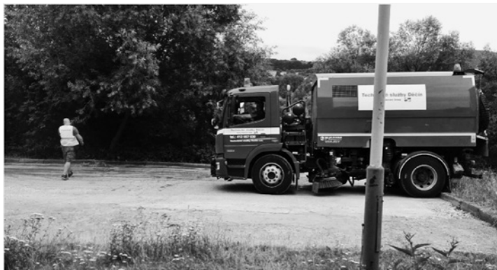
Čištění parkovacího stání před postřikem a pokládkou ve Spojové ulici
