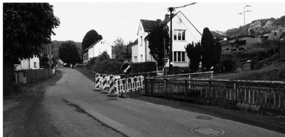
Dopravní omezení v místě rekonstrukce mostu Za Drahou
